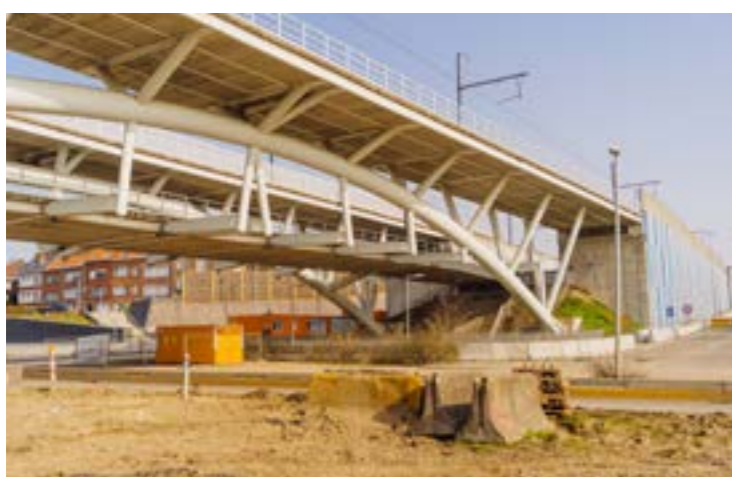
R22 - Machelen - Réfection de l'avenue de Woluwe
