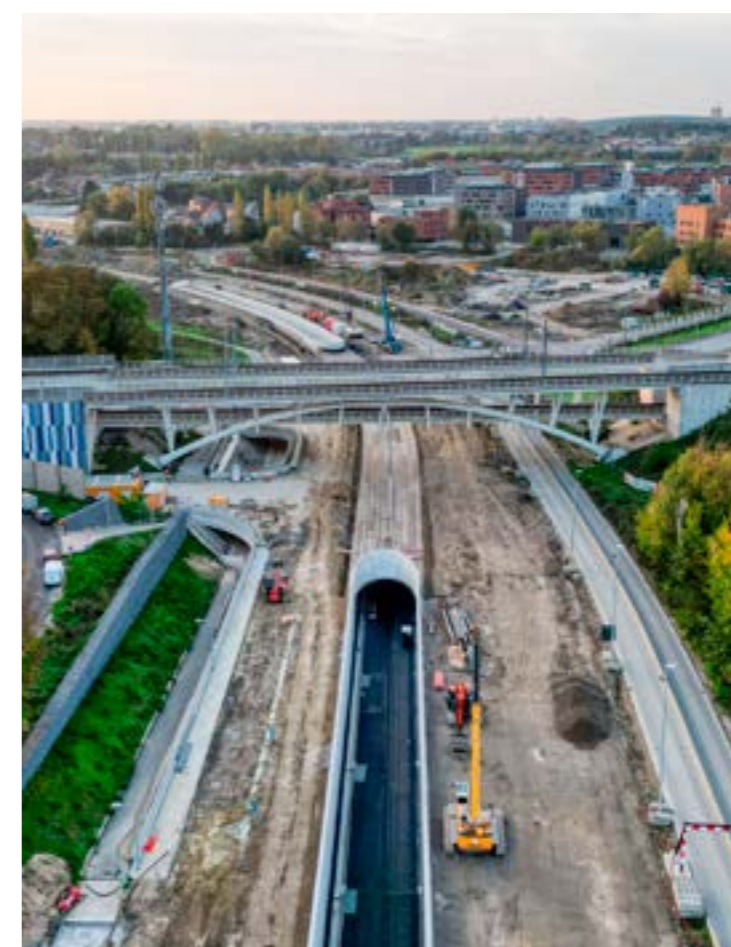
R22 - Machelen - Réfection de l'avenue de Woluwe
